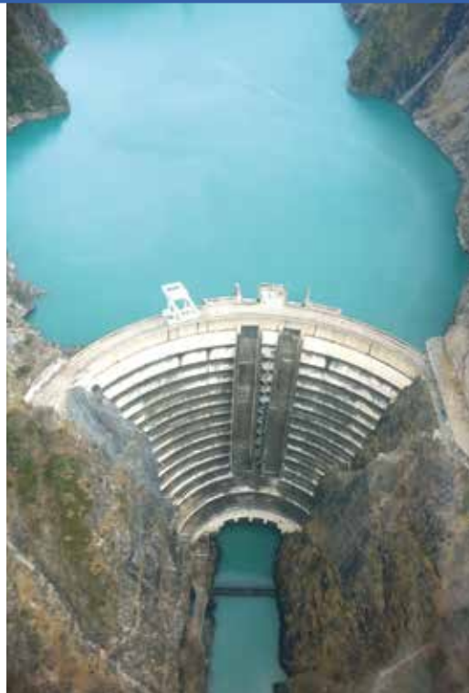
Barrage de Monteynard-Avignonet.
