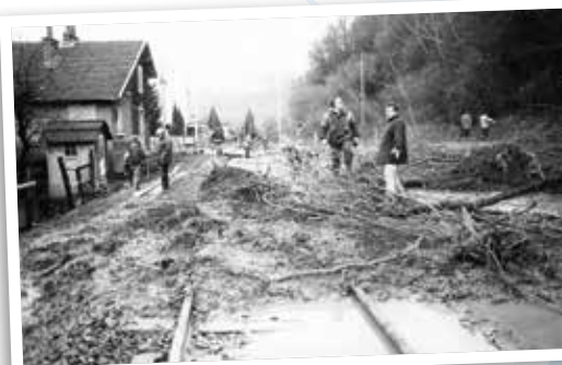
Lors du glissement de terrain de 1994, lieu-dit Le Sert.
